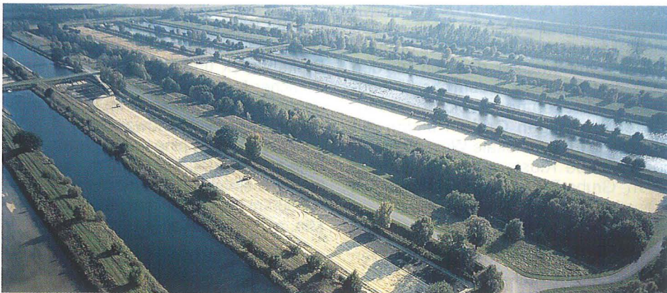
Abb. 42 Das Wasserwerk Haltern mit Filterbecken zur Grundwasseranreicherung durch Talsperrenwasser; Leistungsfähigkeit der Anlage: 106 Mio. m 3 /Jahr
